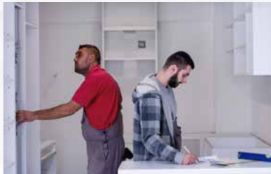
Figura 6- Instalação de um armário na cozinha
